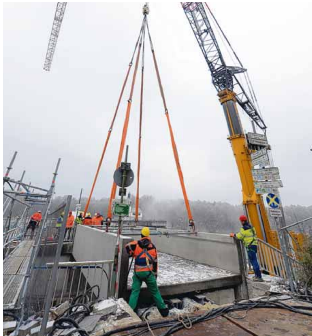
Gestern wurden von einem Autokran die 60 Tonnen schweren Steg-Betonelemente auf die Hochablass-Pfeiler gehoben. Für die Bauarbeiten mussten Teile des Stegs zuvor abgerissen werden. Fotos: Silvio Wyszengrad
